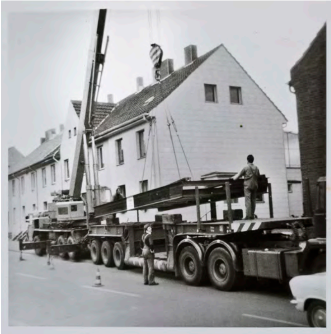
Verladen einer Waagenbrücke
