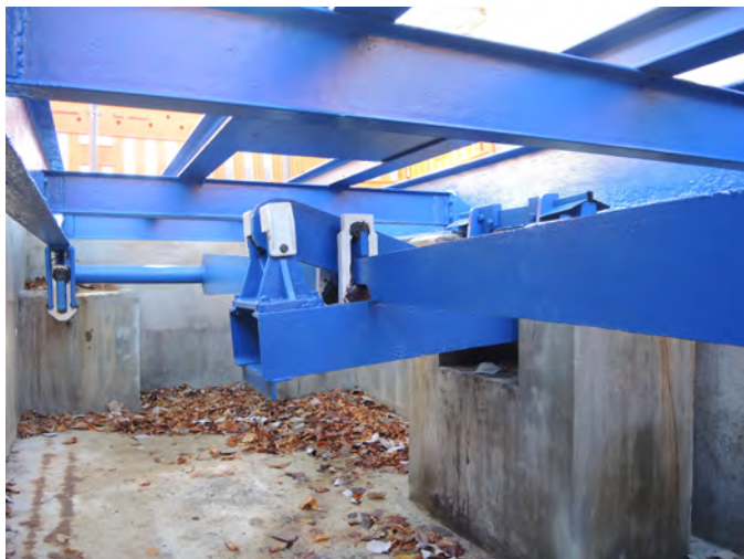
6 Die stählerne Waagkonstruktion wurde nach erfolgter Restaurierung im Herbst 2017 in die Waaggrube eingesetzt und ist nun wieder in funktionsfähigem Zustand. © Markus Numberger, Esslingen
