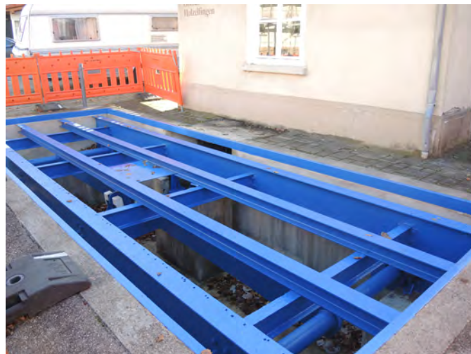
3 Die restaurierte und neu beschichtete Waagenkonstruktion, Oktober 2017. © Markus Numberger, Esslingen
