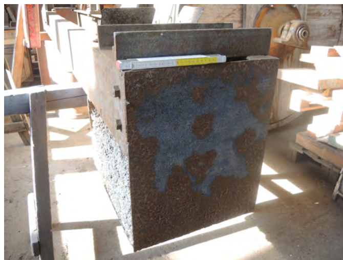
5 Während der Reinigung wurden bläuliche Farbbefunde an der Konstruktion freigelegt. © Markus Numberger, Esslingen
