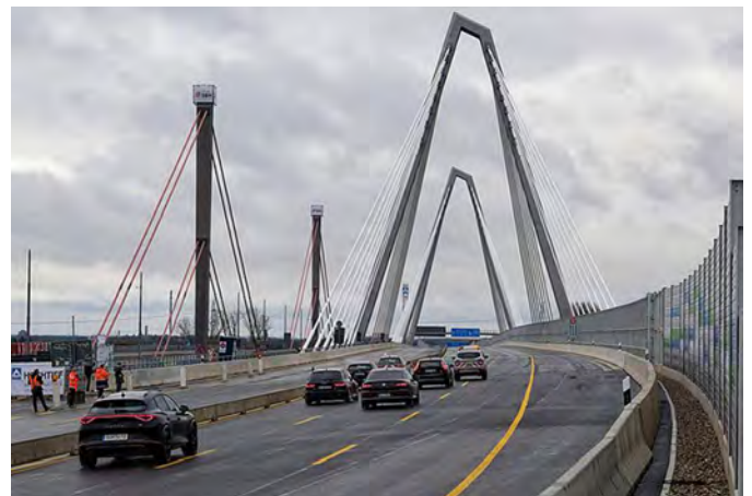
Im Februar 2024 wurde die erste Hälfte der neuen Rheinbrücke bei Leverkusen (rechts) in Betrieb genommen. Die alte Brücke (links) wird abgerissen und dann dort die zweite Hälfte der Neubau-Brücke errichtet. © straßen.nrw
