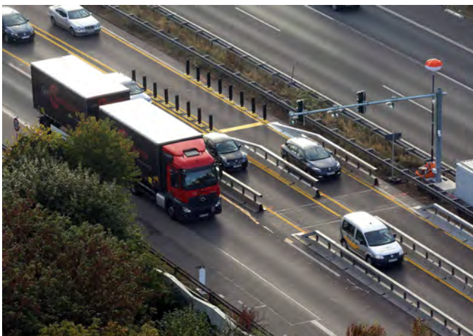
Ableitung der Lastkraftwagen von BAB A1 © Uwe Miserius
