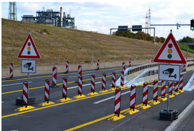
Videüberwachung an der A 59 (Zufahrt zur A1 Rheinbrücke) bei Leverkusen © straßen.nrw
